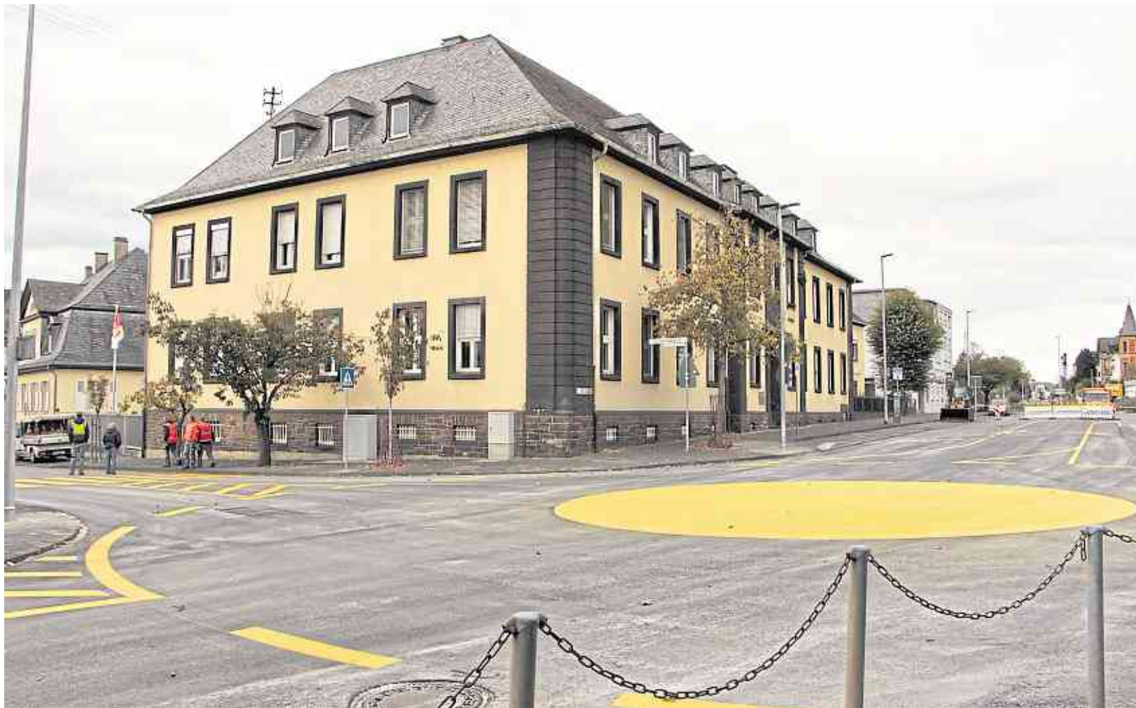
Der Kreisverkehr ist fertig. Die Ortsdurchfahrt Niederlahnstein ist wieder frei.
